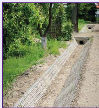
Budowa odwodnienia drogi w Ludwinowie
