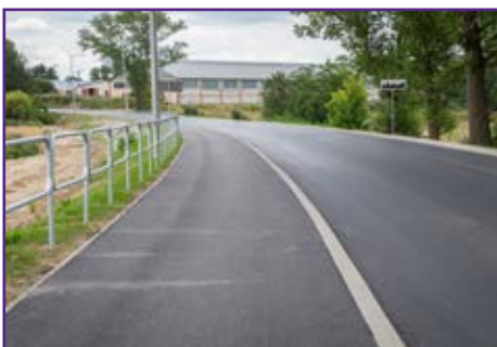
Przebudowa drogi powiatowej nr 2216L na trasie Elizówka – Dys. Około 3 kilometrowy odcinek drogi został poszerzony do zasadniczej szerokości 6 m, a w jego ciągu wykonano chodnik ze ścieżką rowerową i energooszczędnym oświetleniem. Wartość inwestycji to 3,4 mln zł. Inwestycja w 85% sfinansowana ze środków UE.
